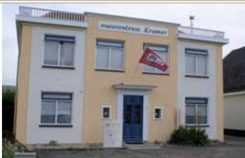
Het geheel gerestaureerde en vernieuwde pand te Westervoort.
