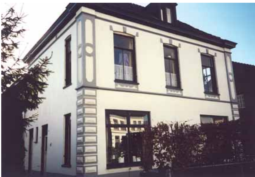
Het pand aan de Zuider Parallelweg nr. 16/17 te Velp.
