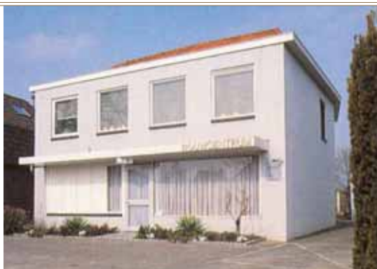
Het pand Hamersestraat te Westervoort na de eerste verbouwing.
