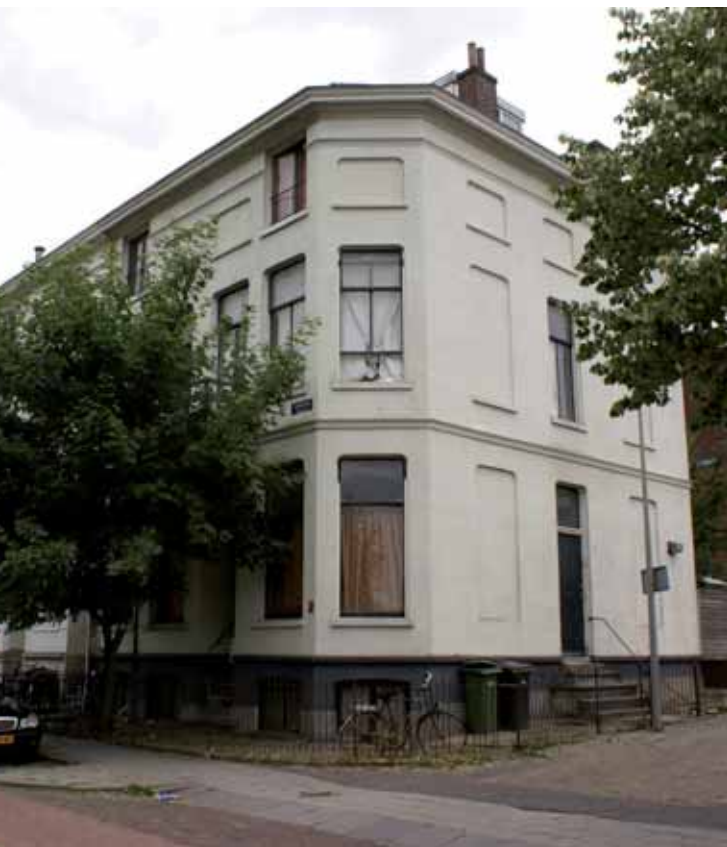
Het woonhuis/kantoor aan de Sonsbeeksingel nr. 55.
