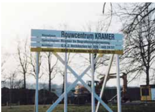
De start van de nieuwbouw van het rouwcentrum Kramer.
