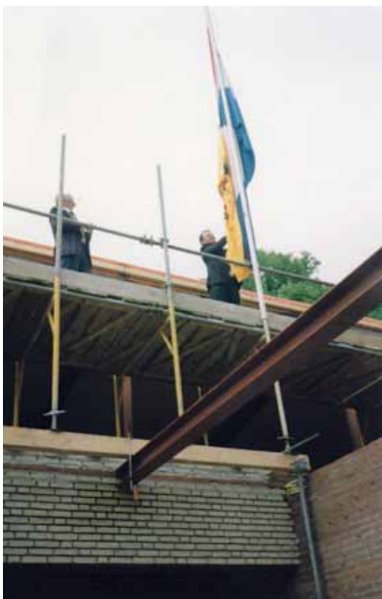
Het hoogste punt bereikt, de vlag wordt geplaatst door de heren Van Dijk.
