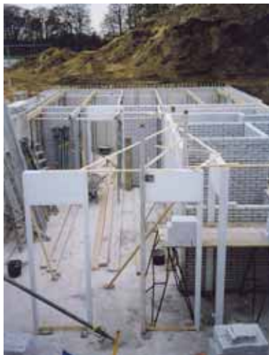
Een impressie van de bouw.
