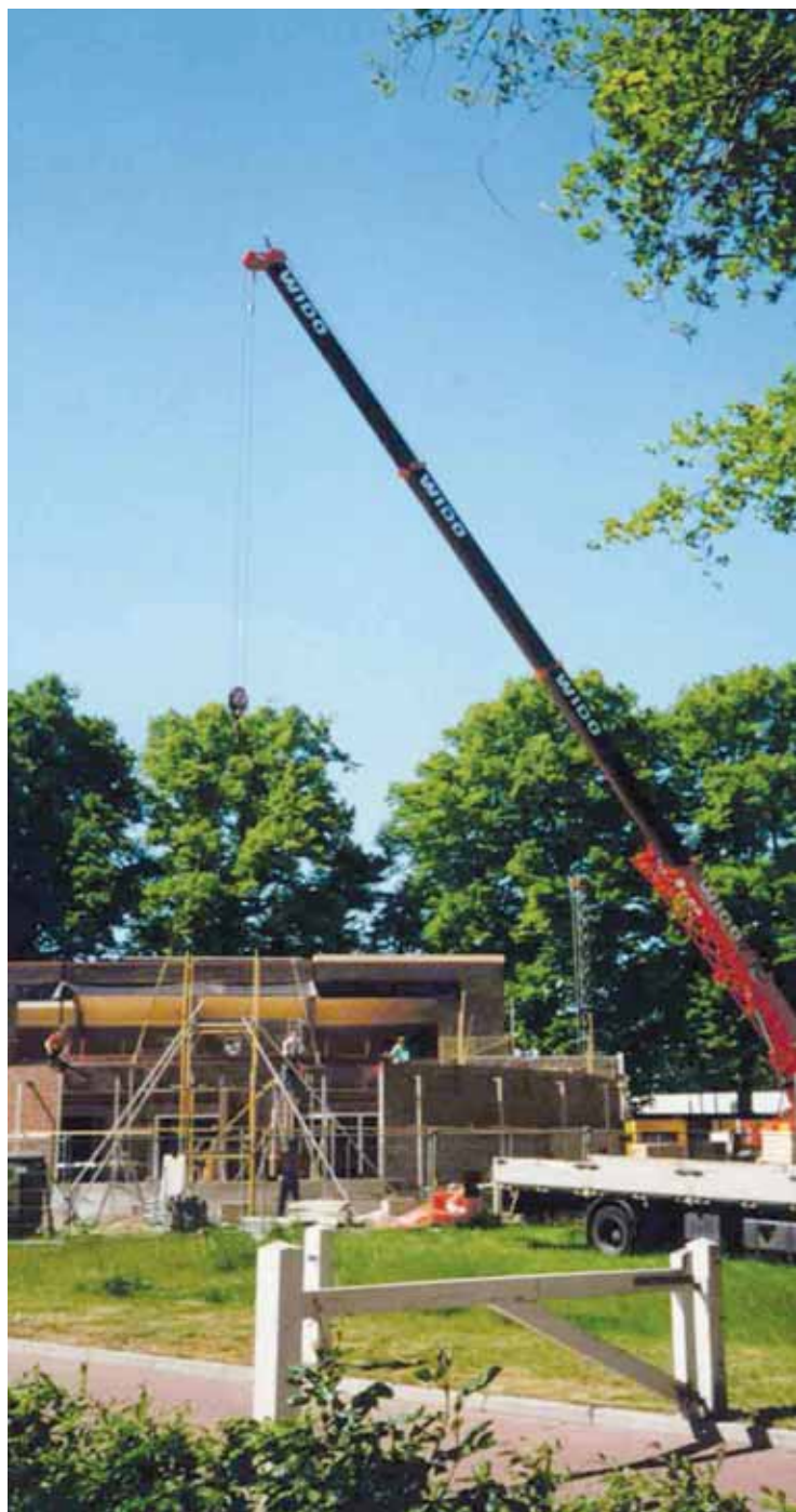
De nieuwbouw enkele maanden later. Het aanbrengen van stalen balken.
